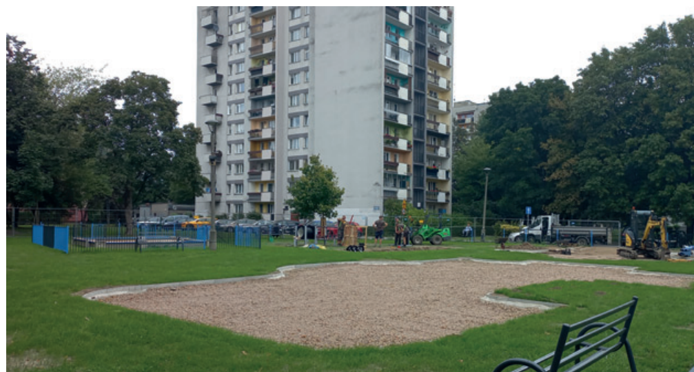
Modernizacja placu zabaw, Os. Wysokie
