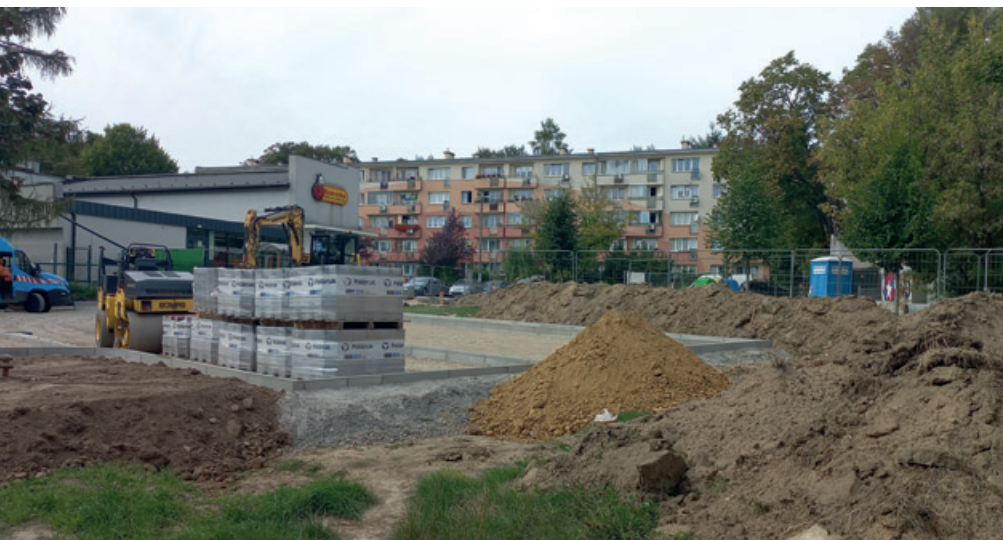
Budowa parkingu, Os. Jagiellońskie
